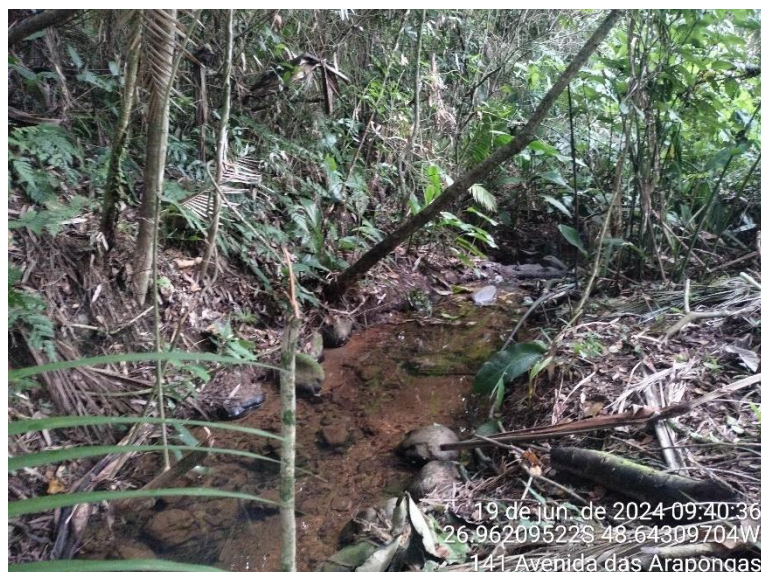
Figura 5 – Calha do córrego na área central.
