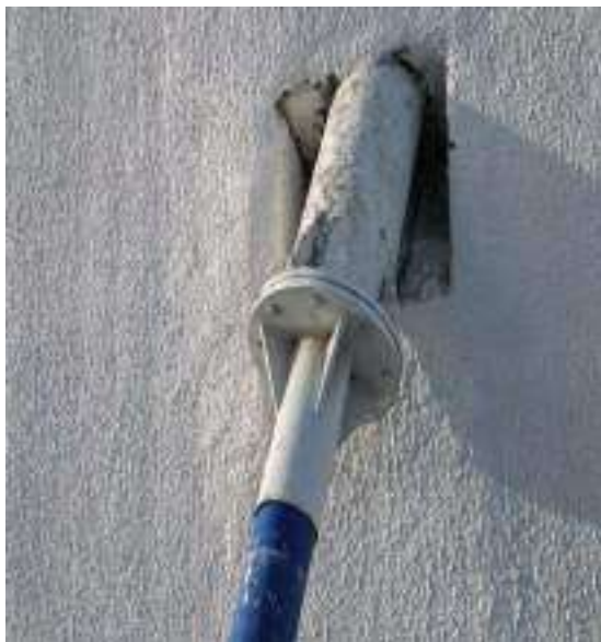
VISTA DO ACABAMENTO E TUBO FORMA DO ESTAI E4 P1-MONTANTE IATE, NÃO SE PERCEBE NENHUM SINAL DE OXIDAÇÃO.
