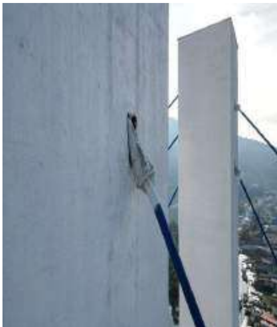
VISTA DO ACABAMENTO E TUBO FORMA DO ESTAI E4 P2-MONTANTE BARRA, NÃO SE PERCEBE NENHUM SINAL DE OXIDAÇÃO.
