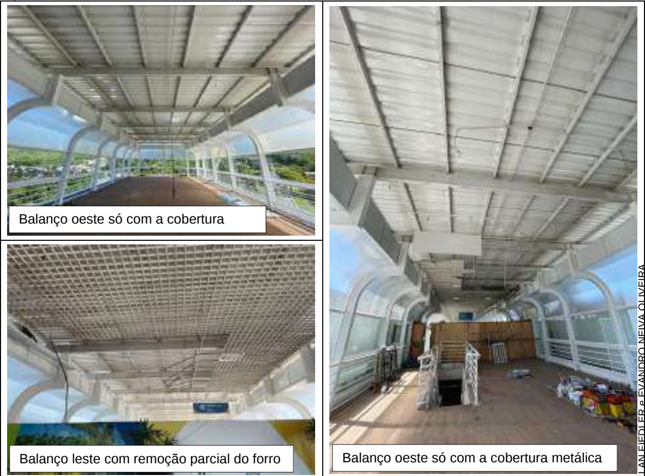
Figura 13 – Reforma dos elementos do teto
