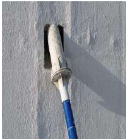
VISTA DO ACABAMENTO E TUBO FORMA DO ESTAI E4 P1-JUSANTE IATE, NÃO SE PERCEBE NENHUM SINAL DE OXIDAÇÃO.
