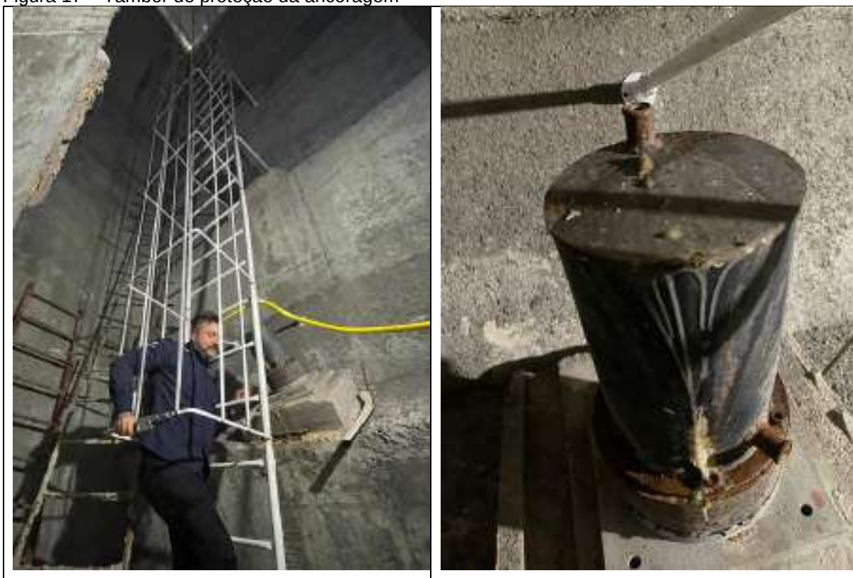
Figura 17 – Tambor de proteção da ancoragem
