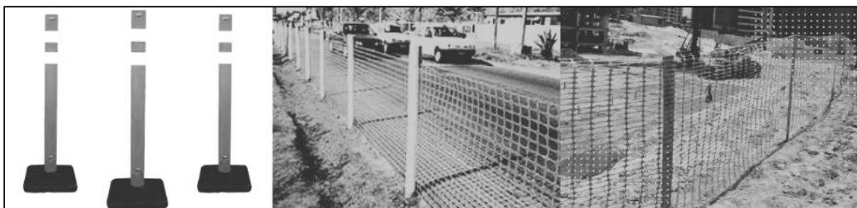
Figura 36 - exemplos de instalação de tapume de pvc
